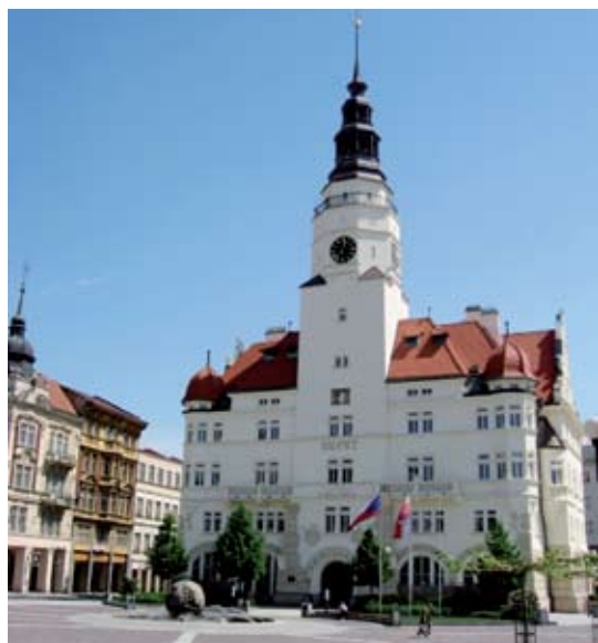
Siedziba czeskiego sekretariatu Euroregionu Silesia znajduje się w budynku Magistratu Miasta Opawy, zwanym „Hláška”, czyli „Wieża Strażnicza”, który jest dominującym punktem Opawy. Zdjęcie: archiwum Euroregionu Silesia
